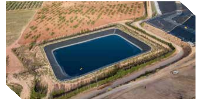
« Leachate Collection New Cells
